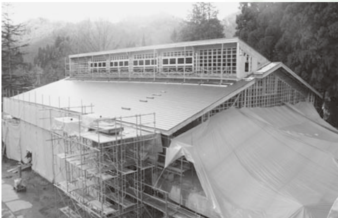
大切に使われる税金（金山小学校体育館の改築工事）
