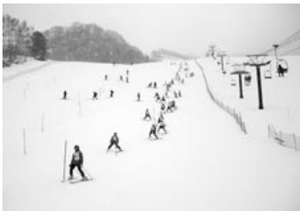
利用者の安全確保のため改修が必要なかねやまスキー場
