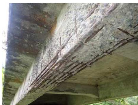
写真-4 RC橋 主桁の鉄筋露出
