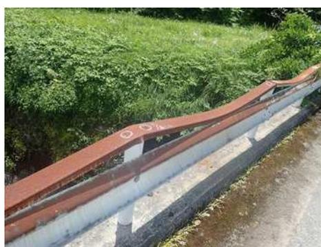
写真-8 防護柵の変形
