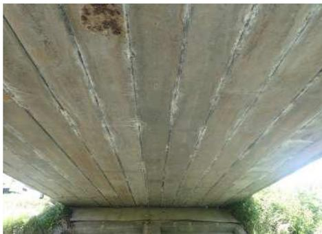
写真-1 PC橋主桁間詰部からの遊離石灰
