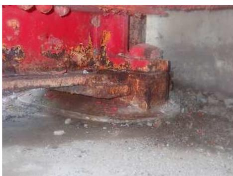
写真-3 支承の腐食
