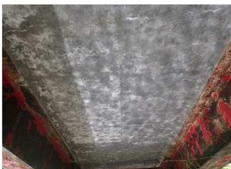
写真-5 RC橋 床版ひびわれ
