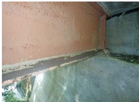
写真-2 鋼桁の塗装劣化
