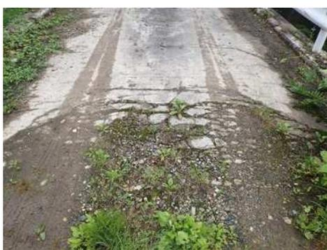
写真-7 舗装のひびわれ
