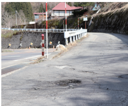
舗装工事が行われる町道水沼沼沢線
