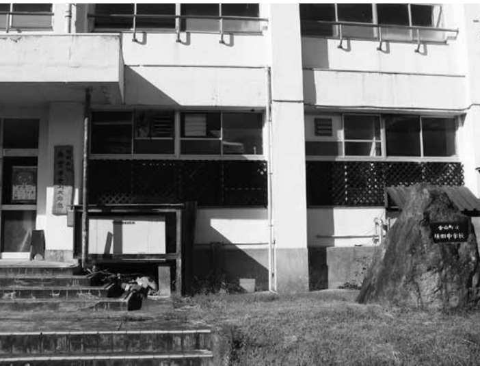
加工所が整備された旧横田中学校校舎 (株)奥会津金山大自然が利用(横田地区)
