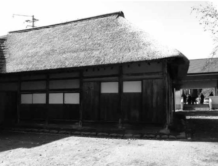
今年度屋根葺き替えが完了した旧五十島家住宅 県の重要文化財(中川道の駅) 室内の民具を含め観光素材となるのか
