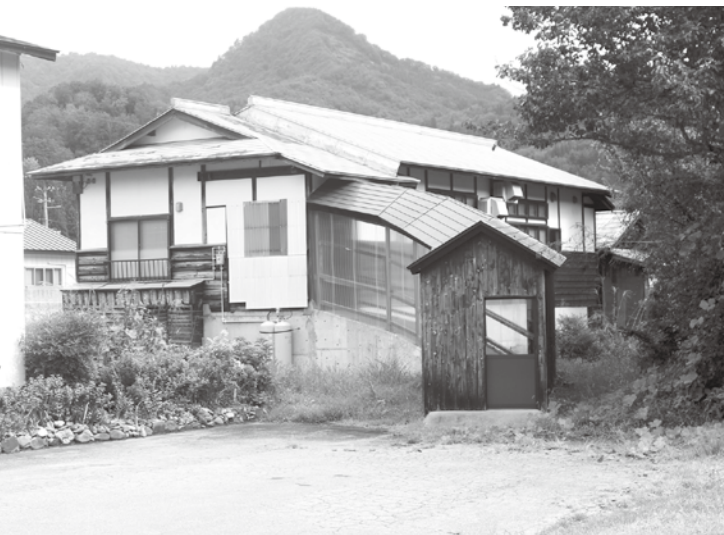
金山町多目的共同住宅(上横田地区) 冬の高齢者共同住宅としての利用は少ない 柔軟で有効的な利活用が求められている
