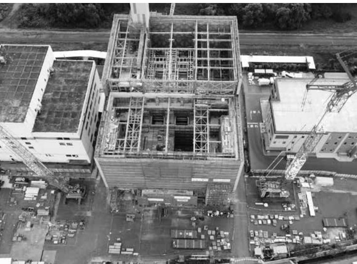
建設工事中新ごみ焼却施設(中央:R6.6) 令和8年3月稼働予定(会津若松市) 左が既存ごみ焼却施設
