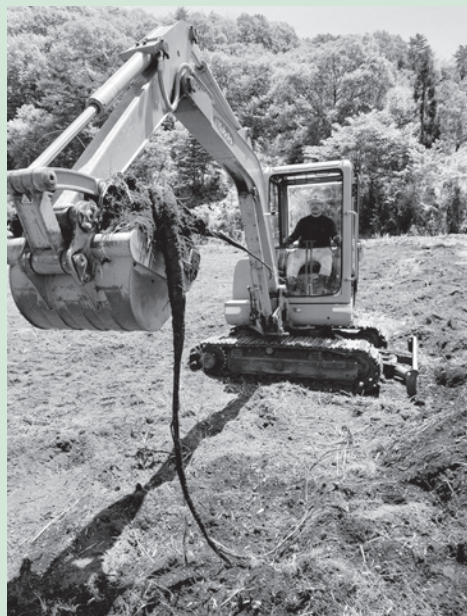
バックホー作業はお手の物
