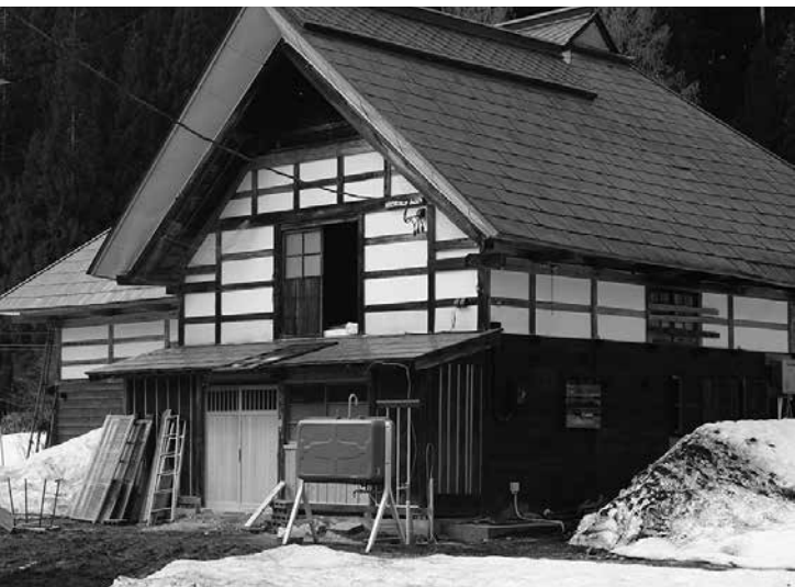
空き家古民家を大規模改修し宿泊施設へ(玉梨地内)
