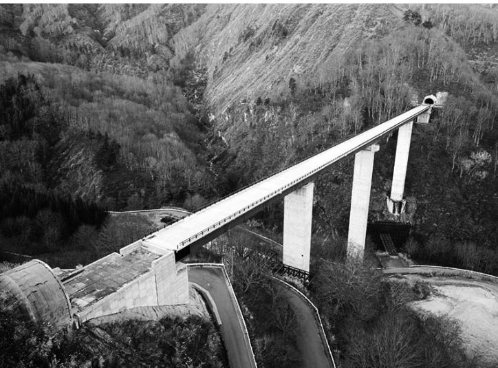
令和8年開通見込みの国道289号（八十里越） 新潟県側第5橋梁（L＝337m）
