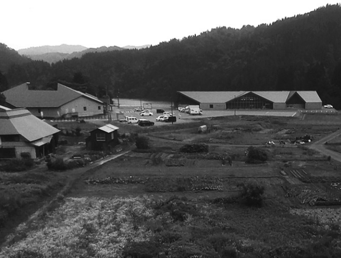
災害時、防災拠点となる 「道の駅奥会津かねやま」周辺
