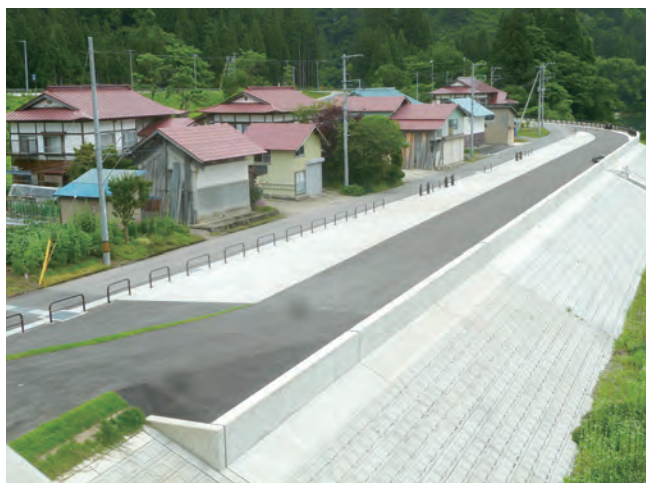
工事が完了した湯倉地区(本名地内)
