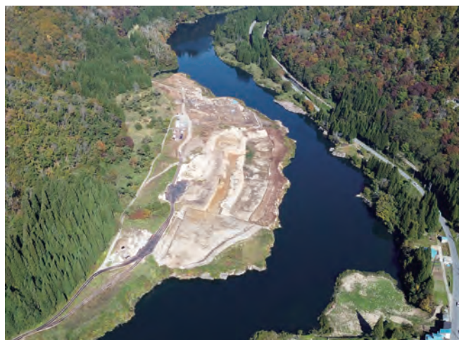
大規模な岩盤掘削により河道掘削工事が進んでいる中 西部地区(大塩地内)
